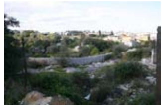
MA1212 - Residui di recinzione realizzata con muretti a secco nel lato Sud della Cava
