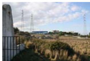
MA1402 - In primo piano la struttura di protezione del sito e sullo sfondo il Palaenichem
