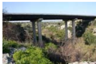
TA208 - Il cavalcavia della SS114 a Ovest del sito
