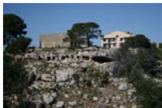
MA1507 - Edificio abbandonato alla sommità del lato Nord del sito
