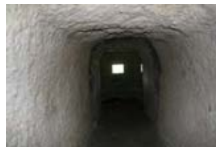
TE1512 - L'interno del bunker
