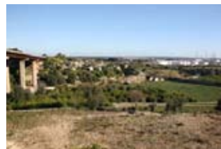
TE602 - La Cava e uno degli impianti del Petrochimico
