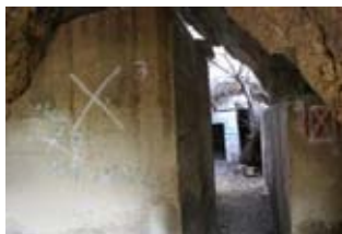
TE1511 - L'interno del Cozzo Telegrafo, con le strutture riconducibili al bunker
