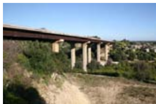
TE601 - Il cavalcavia della SS114 sulla Cava Baratta
